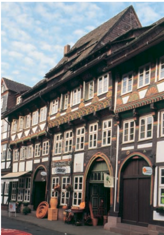
Tiedexer Str. 20–22 (v.r.n.l.), typische Einbecker Brauhäuser mit großen Dielentoren und z.T. noch mit dem ursprünglichen hohen und steilen Dach.
